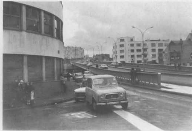
Le pont Saint-Jacques, viaduc qui permet de se rendre à pied au restaurant universitaire.
