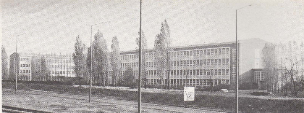
Le nouveau lycée Faidherbe
