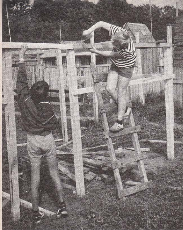
Construction d'une cabane
