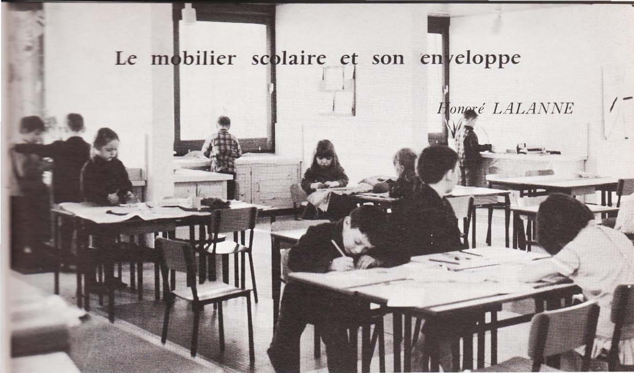
Classe expérimentale de Châteauroux (Csali architecte)
