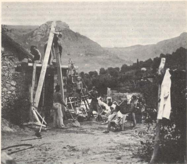
Les premiers murs de l'École. Freinet se trouve en haut, à gauche.
