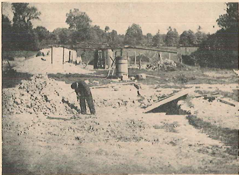
Ancien terré et malaxeur à cheval
