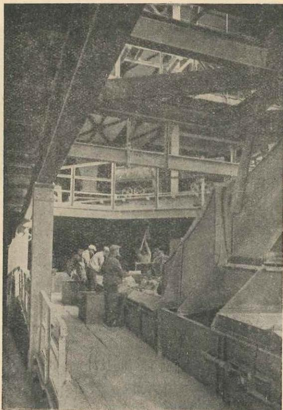
*Le triage. — On sépare les blocs de schiste ou de sel gemme se trouvant parmi les blocs de potasse*
