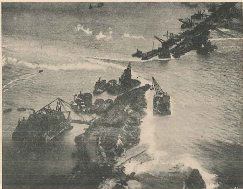
Le torrent d'eau n'est pas encore dompté. Note que pour parvenir à obturer le passage, il faut construire la digue incurvée. On la redressera ensuite.
