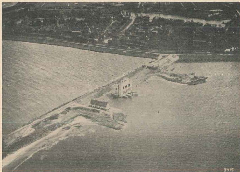
La station de pompage Lély en action. On voit distinctement que l'eau a baissé dans le futur polder (au premier plan).
