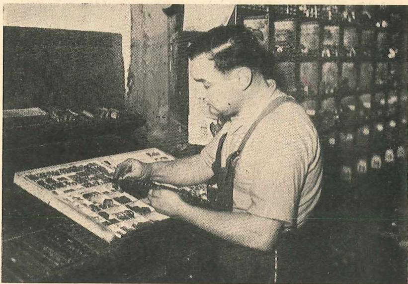
Le typographe composant à la main (devant lui, une « casse ») (Photo "Liberté de l'Est")
