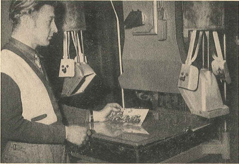
La photogravure L'appareil à agrandissement (voir page suivante) (Photo "Liberté de l'Est")
