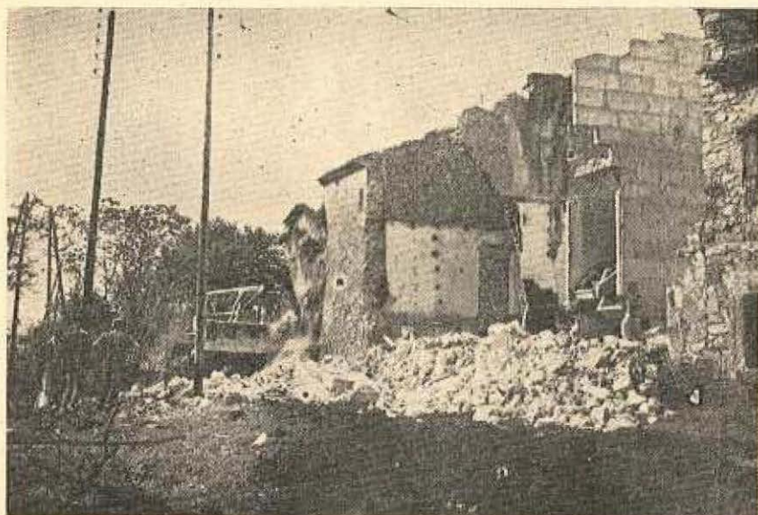
Les constructions existantes sont démolies sur le tracé du canal
