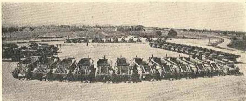
Les machines pendant le repos
