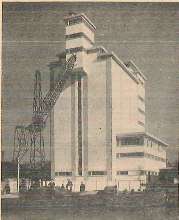
Le vaste silo à grains de la Coopérative agricole de Reims (capacité, 26.500 q.)
