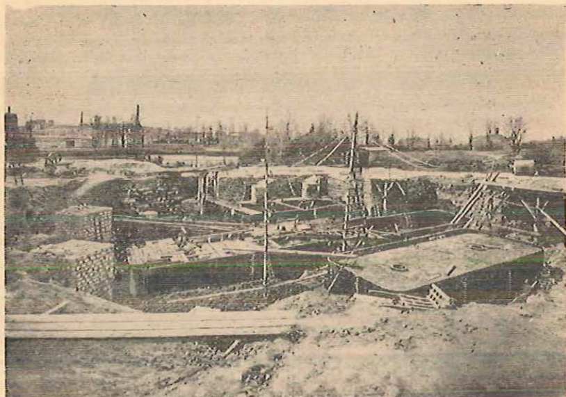
Les travaux au 3 e mois (13 avril 1887)
