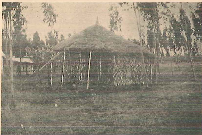
Quelquefois les troncs sont si serrés qu'on ne met pas de « tchica »
