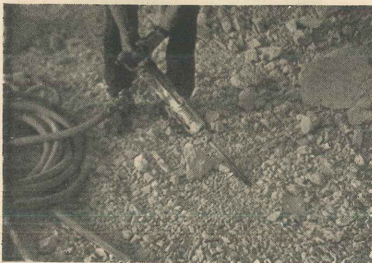
La perforeuse. — L'air qui actionne le burin est amené par un tube métallique
