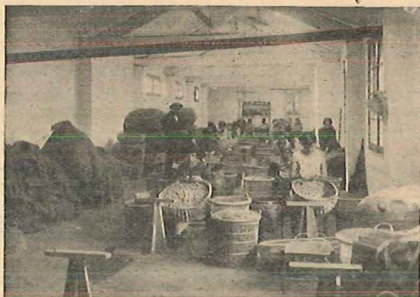
Le triage des bouchons se fait à la main L'ouvrière classe d'abord en trois qualités. Chaque qualité est encore dédoublée.
