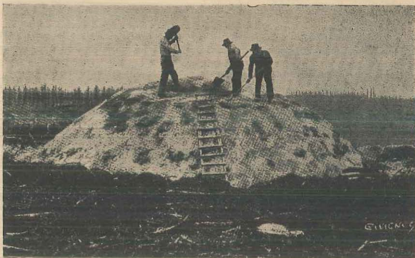
La fabrication du charbon de bois Autrefois : le procédé des meules
