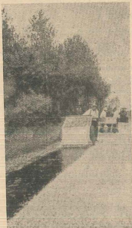
On a incorporé des brais aux goudrons qui servent à revêtir les routes
