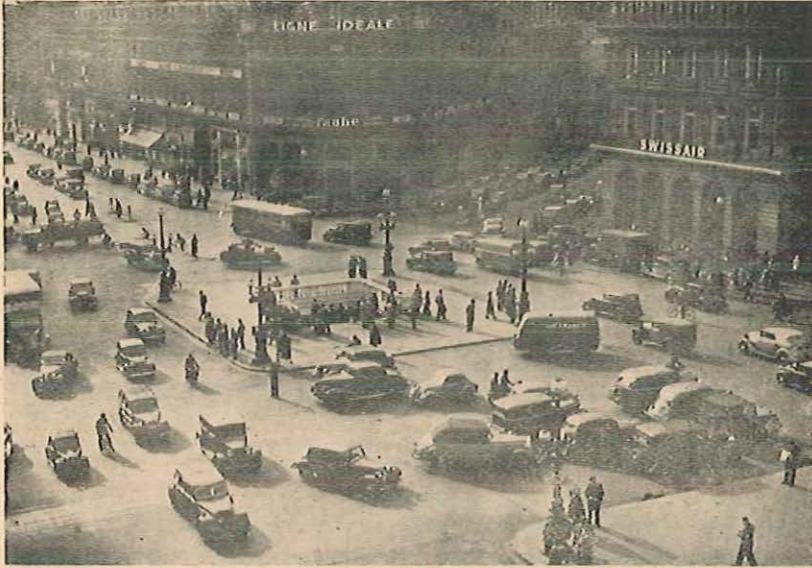
L'encombrement des rues
