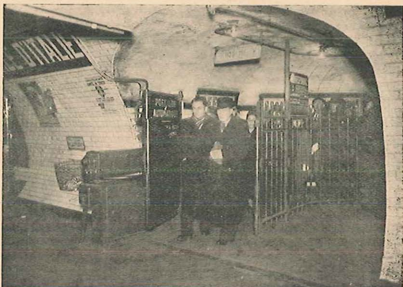
Ouverture d'un portillon automatique
