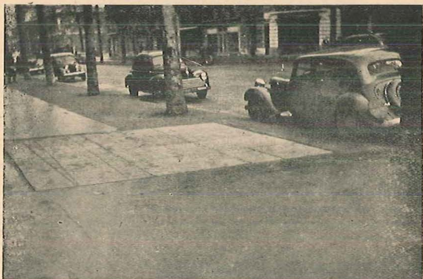
La bouche d'aération. Vous la distinguez sur le trottoir. Elle est recouverte d'une grille métallique par où monte l'air chaud de l'intérieur.
