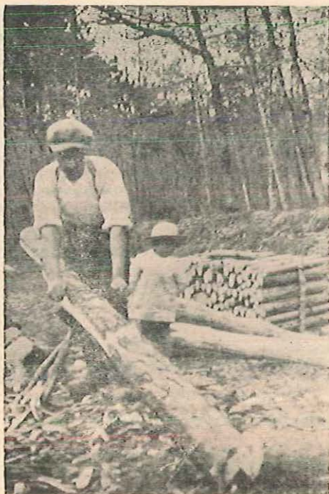
A l'aide de la plane, l'ouvrier écorce les étais de mine posés sur un chevalet. Derrière lui, une pile de bois de chauffage.
