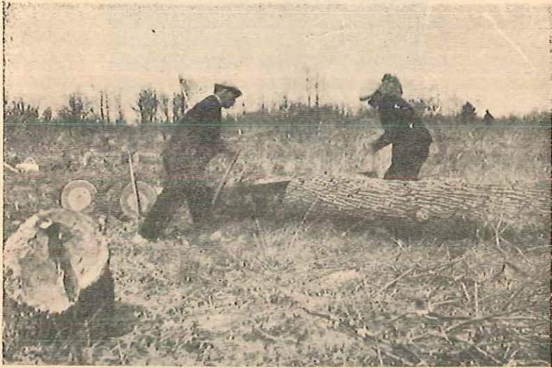
Les arbres sont tronçonnés avec une grande scie : le « passe-partout »
